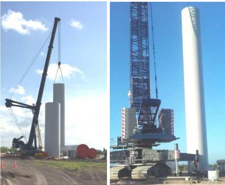
2. Una sección de la mitad inferior de la torre es instalada
