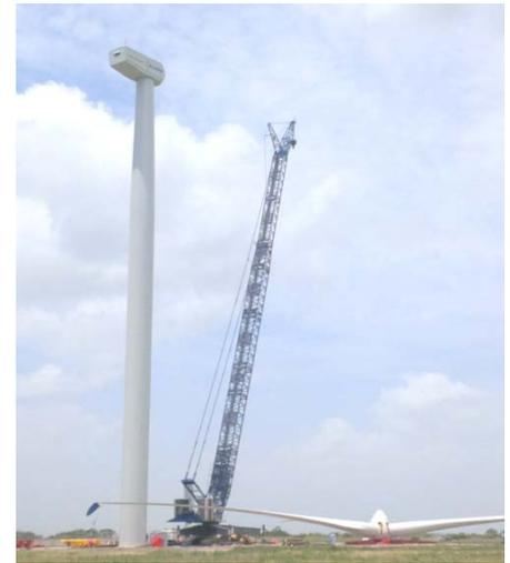
5. Una góndola erigida lista para la instalación del rotor
