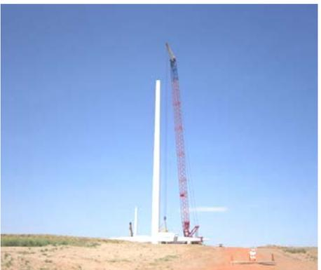
4. Una torre es completamente armada; la góndola y el rotor están siendo preparadas para la erección
