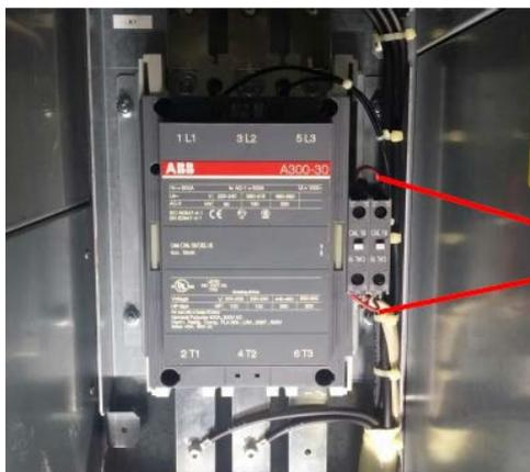
Contactos auxiliares en los que se produjo la descarga eléctrica.
